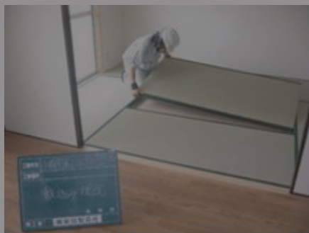
市営住宅の畳を敷き込んでいます。
