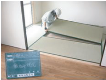
市営住宅の畳を敷き込んでいます。
