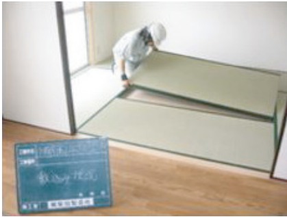
市営住宅の畳を敷き込んでいます。
